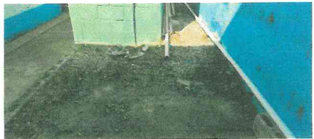
Foto 6: Losa de patio colocacion de concreto
